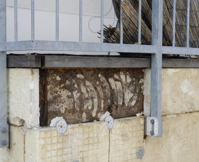
Unter der EPS Wärmedämmung wurde eine nicht geeignete OSB Platte montiert. Die Folge: Schwarze Schimmelbildung auf der Platte.
