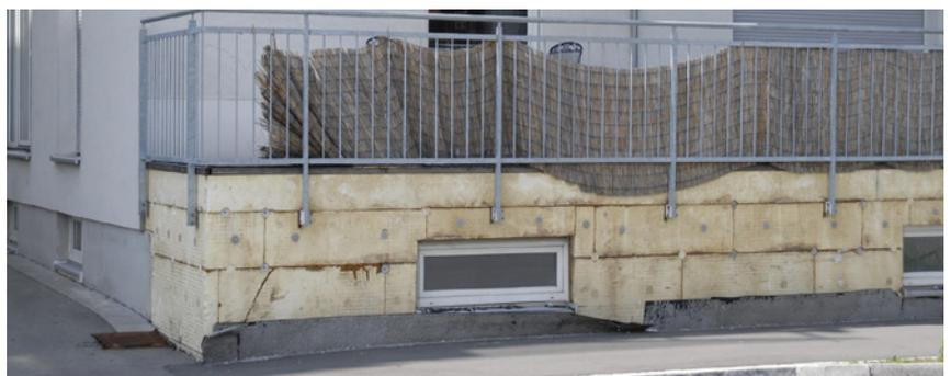
Die EPS-Wärmedämmung platzt ab, weil die Ausführung falsch geplant wurde und billigste Tellerdübel Verwendung fanden.
