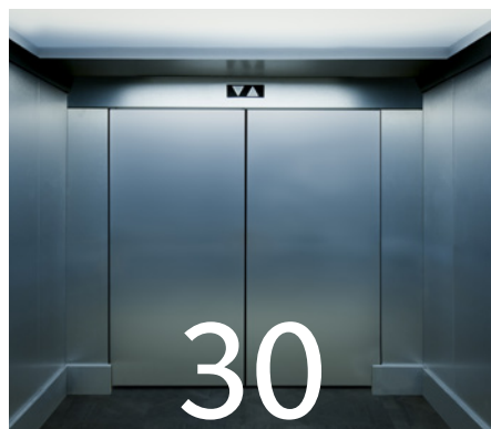
30 Aufzuganlagen: Betreiberpflichten und Haftungsrisiken
