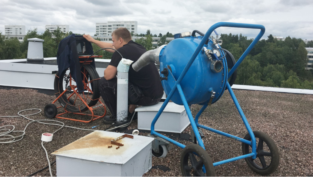
Der Schlauchliner wird vom Dach in die Fallleitung bis in den Keller eingebracht.
