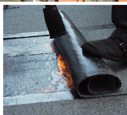
Auf die hinreichende Verschweißung der Nahtverbindungen kommt es an.
