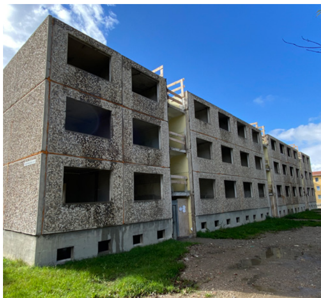
Teilrückbau der oberen beiden Etagen und eines Gebäudesegments
